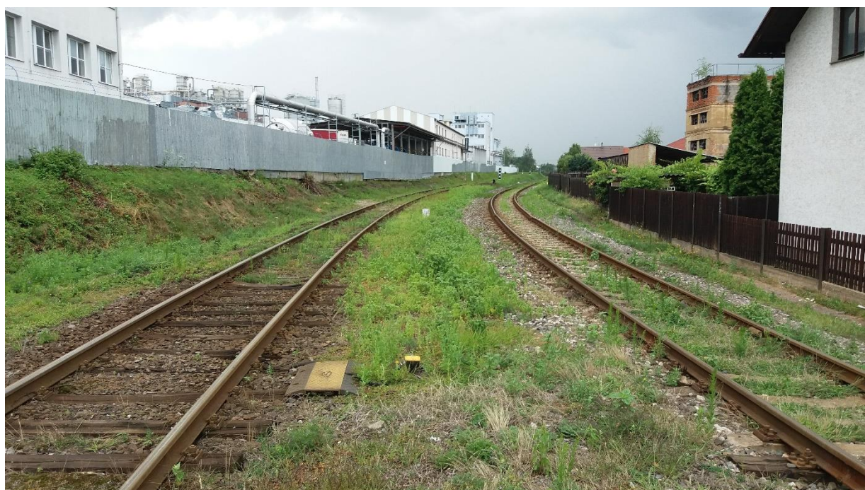
Obr. Pohled na traťové koleje směr Blatno/Kralovice (vlevo) a směr Louny (vpravo) – nestabilní stěna vlevo a podmáčené těleso žel. spodku
