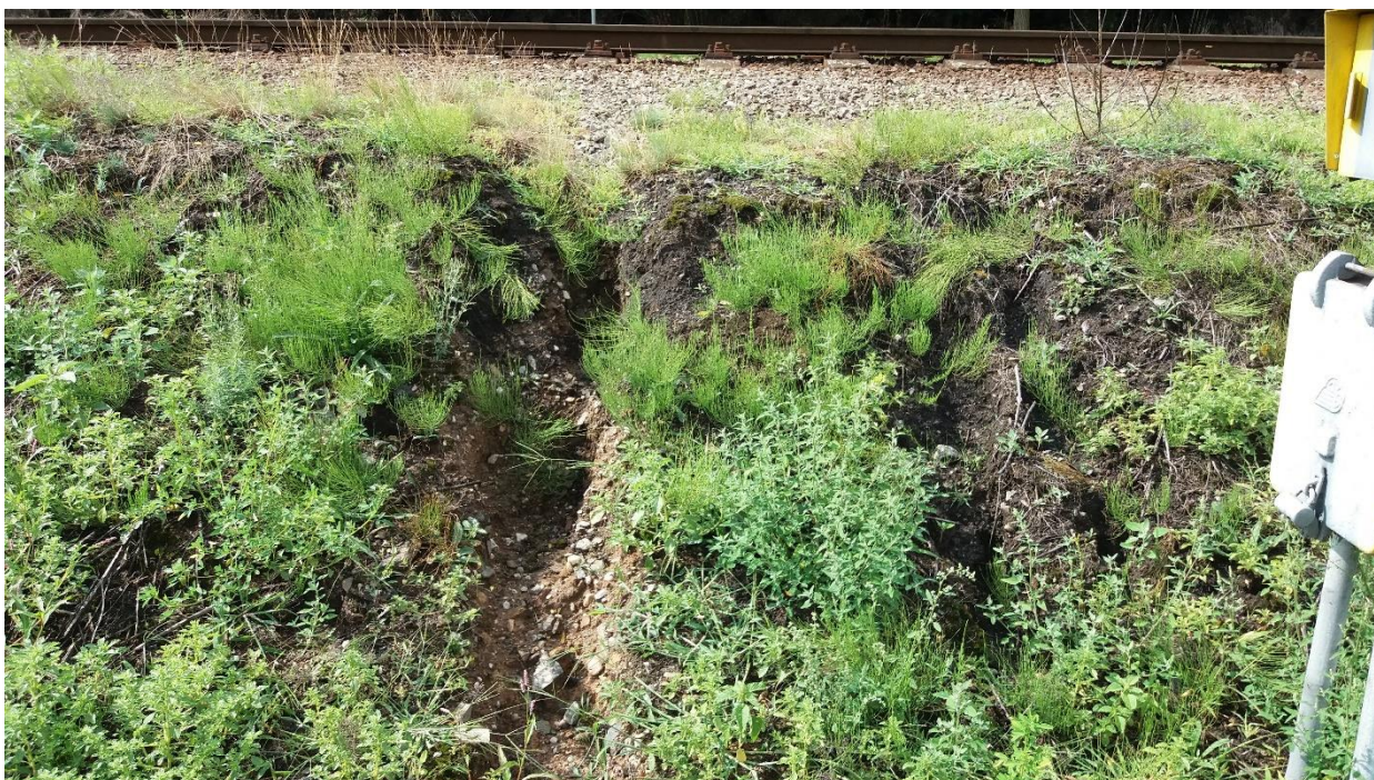
Obr. Žst. Rakovník, eroze terénní nerovnosti mezi kolejemi na Depo a Berounským zhlavím
