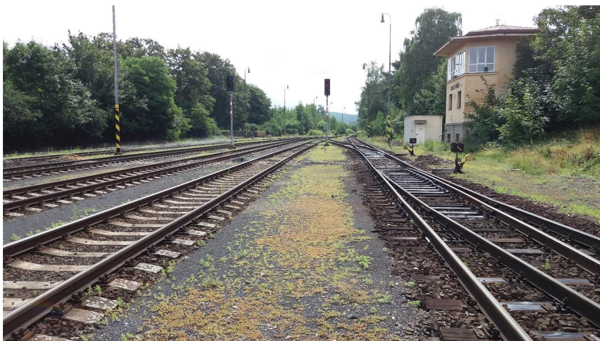
Obr. Žst. Rakovník, eroze terénní nerovnosti mezi kolejemi na Depo a Berounským zhlavím
